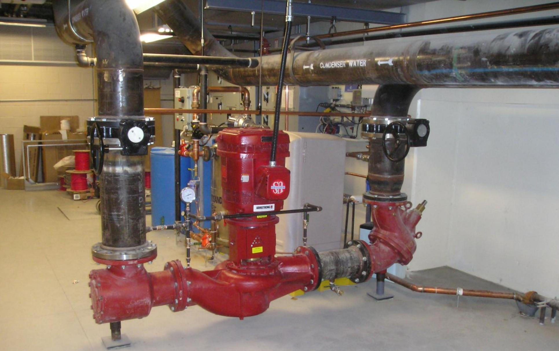
**三件套：立式管道泵+入口导流器+多功能阀**
