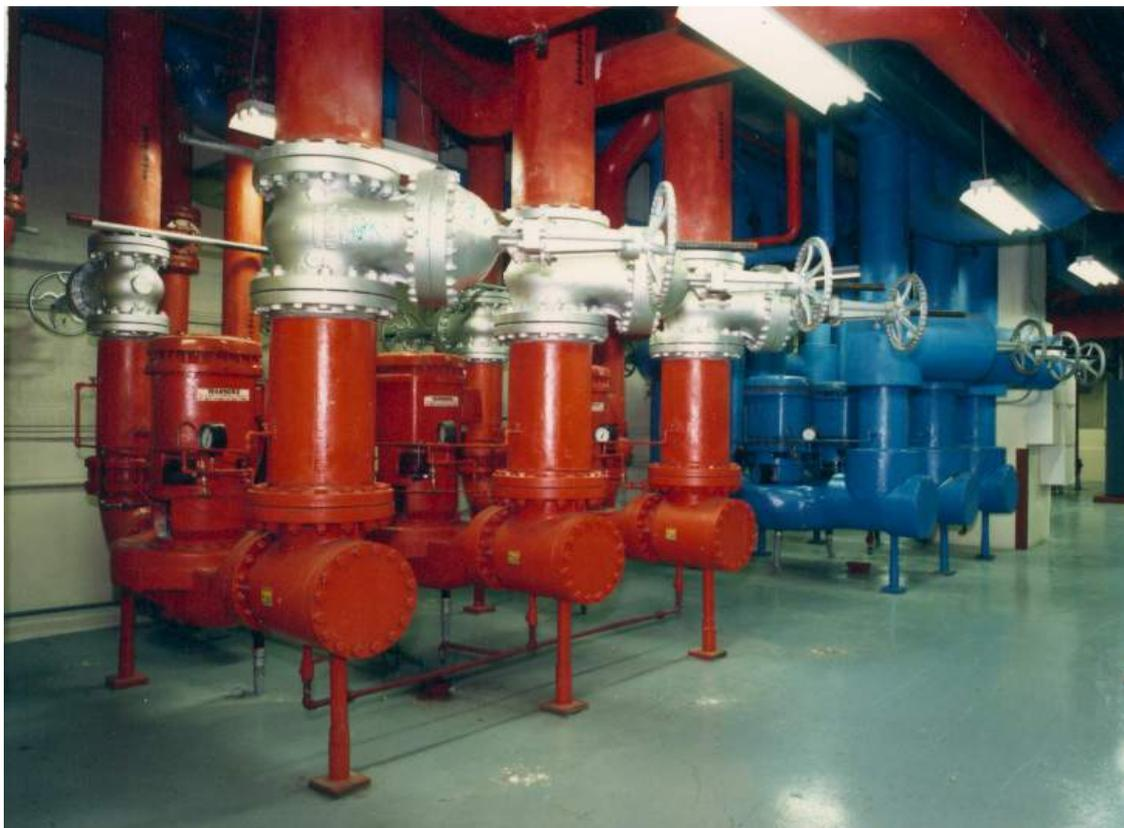
安装立式管道泵就如同安装闸阀一样简单。
