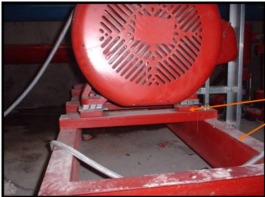
➤水泵安装面与底座面非机械加工面，安装时必须校准同轴度，但总会有误差。
