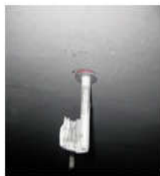
安装完毕的锚栓图例
