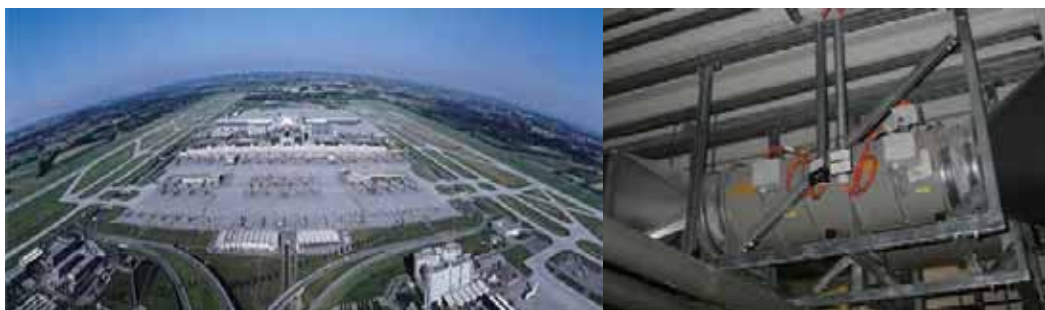
★ 慕尼黑机场第二航站楼支吊架系统
