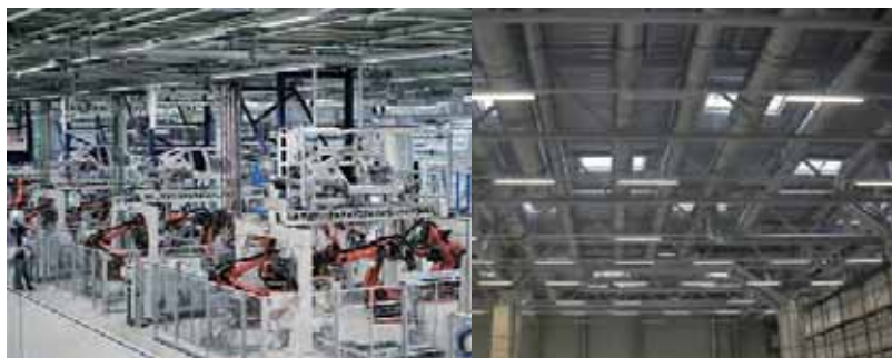
★ 宝马 (沈阳) 工厂支吊架系统 BMW
